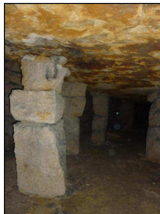
Carrières souterraines - Chambre de dimensions assez importantes confortée par des piliers à bras (état plutôt bon).
