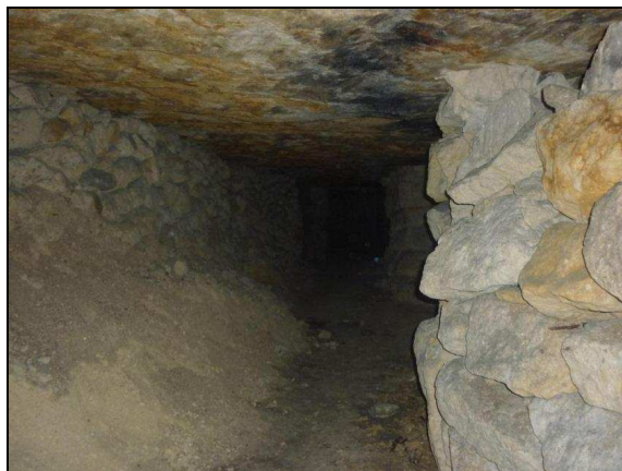
Carrières souterraines - Galerie exploitée par hagues et bourrages, sans consolidation.
